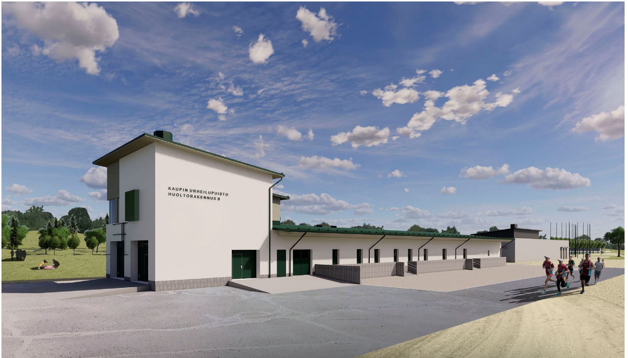
Kuva 23: Kaupin uusi huoltorakennus. Näkymä lännestä. Arkkitehdit Kontukoski.
